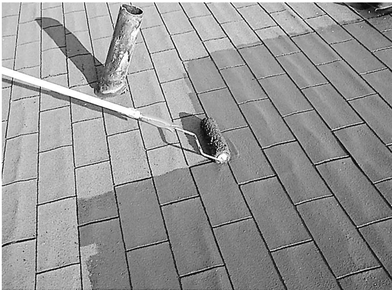
Il existe maintenant un revêtement élastomère performant pour étancher et préserver les bardeaux d'asphalte qui démontrent des signes de vieillissement.
