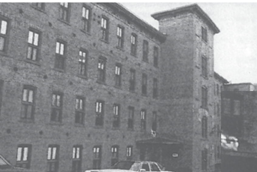
Façade du HLM Place Paton.
