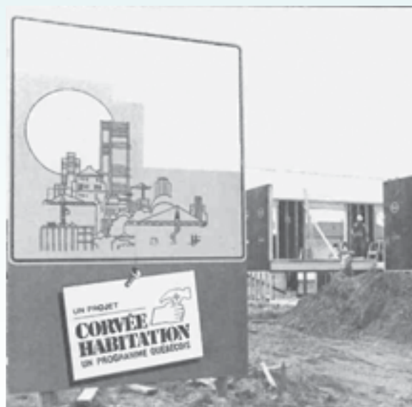
Chantier Corvée-Habitation (vers 1984).
