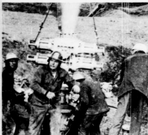
Adair (vu ici de face) surveille la mise en place d'un nouveau bloc de commande à Buick Creek, C.-B.
