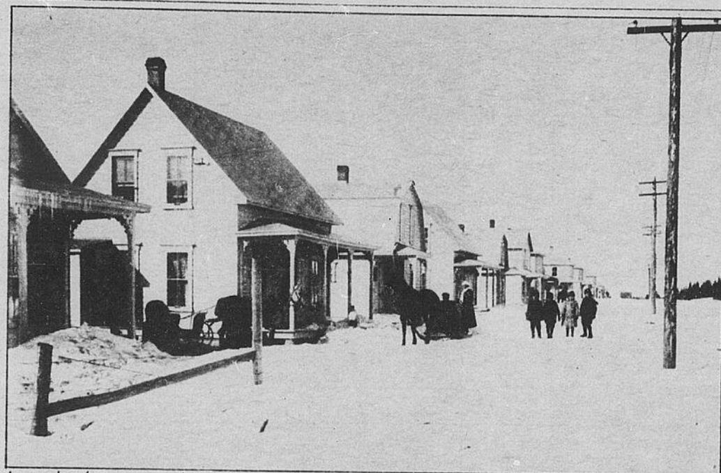
A gauche, le transport du bois dans un chantier (1909) et le moulin de Val-Jalbert (1907); ci-dessus, une rue de Kénogami en 1927.
