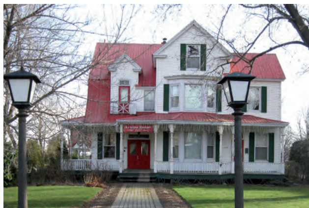
Maison de Pierre Bleau avant (en bas) et après la restauration de ses éléments extérieurs.
