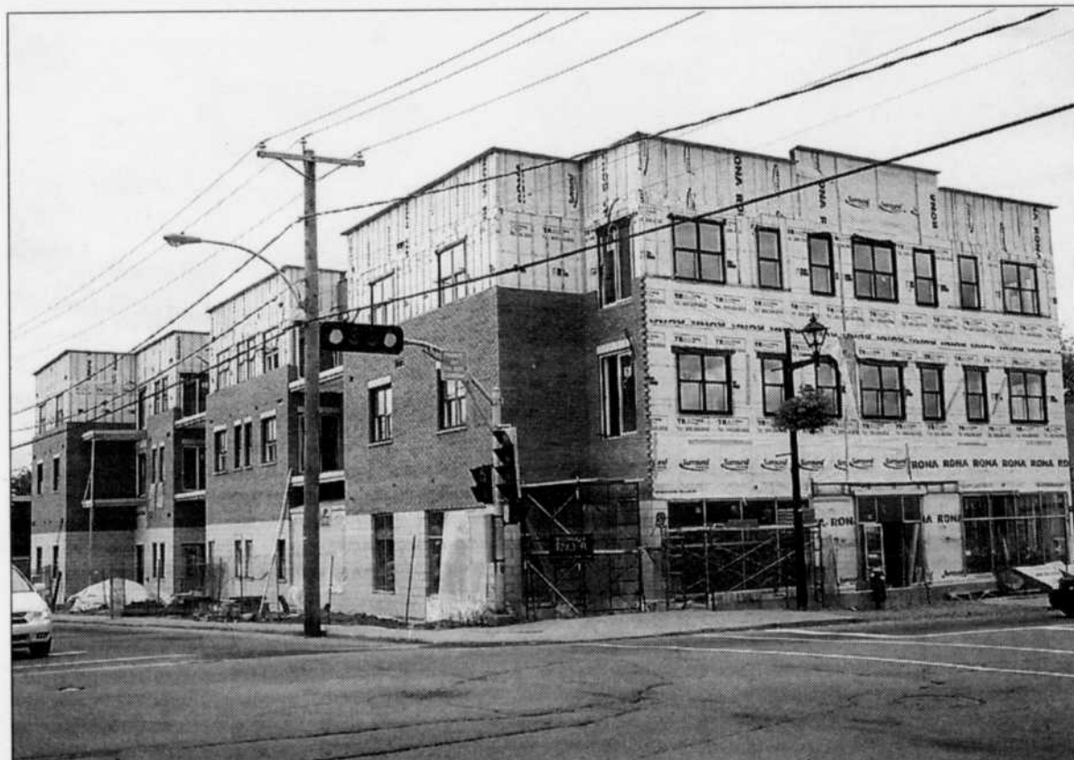
Une page est en train de se tourner sur le terrain en friche depuis 10 ans, à l'angle des rues Saint-Charles et Principale. La construction d'un édifice qui accueillera 30 appartements, avec services, de trois et quatre pièces et demie est pratiquement achevée.
