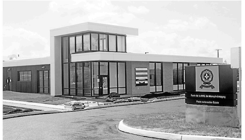
Les travaux de construction du futur poste de la Sûreté du Québec à Magog sont presque terminés. — PHOTO LA TRIBUNE, JEAN-FRANÇOIS GAGNON
