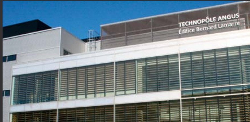
Les infrastructures sophistiquées de l'Édifice Bernard Lamarre ont attiré un locataire de renom.
