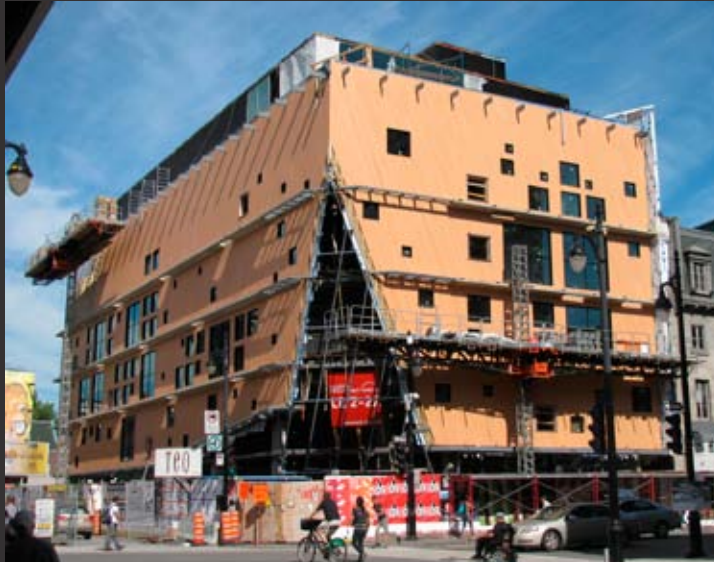
Le 2-22 en construction à l'été 2011.
