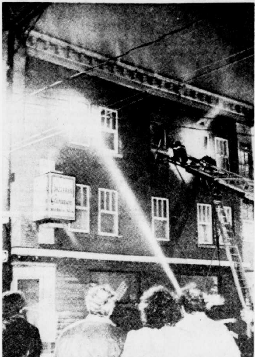
Le feu faisait déjà rage à la grandeur de l'étage dès l'arrivée des pompiers.
