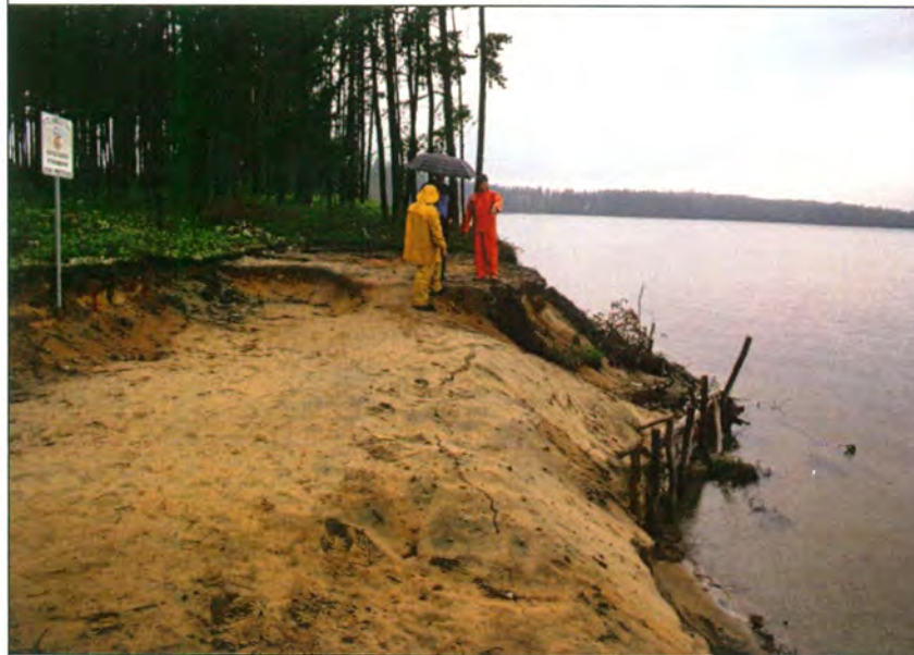
11- Fissure de tension au sommet du talus
