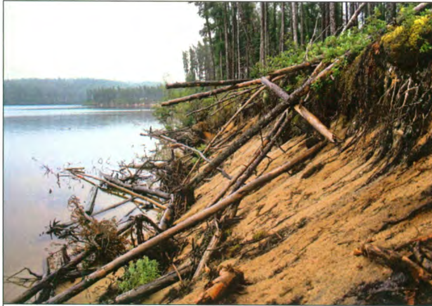
19-Talus vers le sud du site
