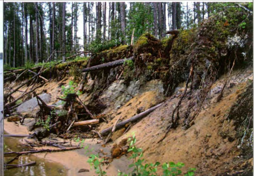
18-Talus vers le sud du site
