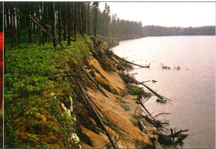
10- Arbres tombés sur le talus à cause du recul du talus
