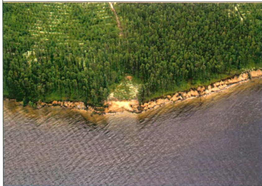
3- Site du cimetière et talus d'érosion
