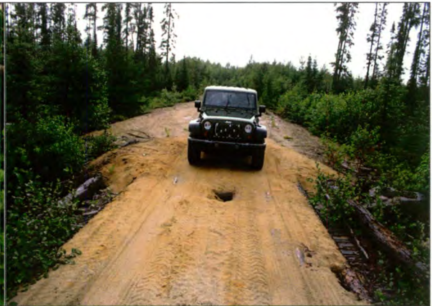
24-Route de sable et graviers vers le barrage
