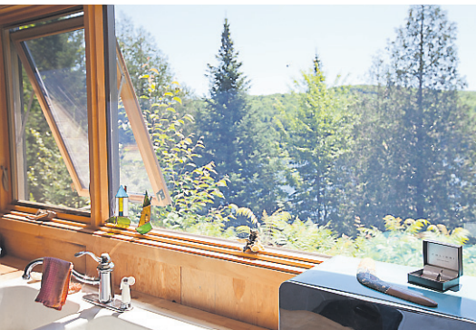
Une vue à partir de la cuisine. La fenêtre à auvent aère l'espace et procure une ventilation naturelle.
