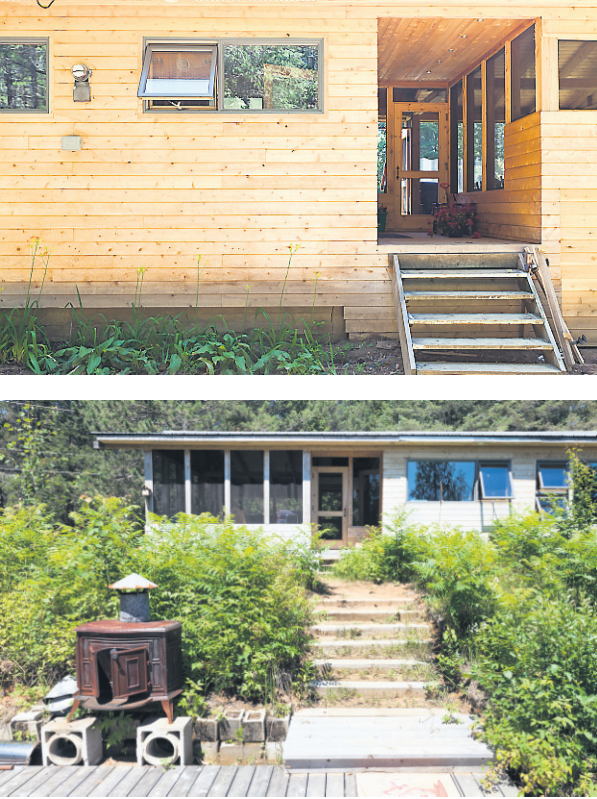
➤ L'entrée côté nord. On remarque que les fenêtres sont hautes pour préserver l'intimité. Photo du bas : la maison vue du lac, à gauche, la véranda.
