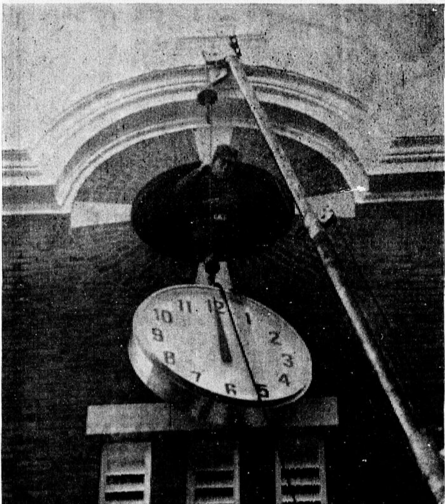
Quatre cadrans lumineux ont été installés la semaine dernière dans la tour de l'édifice municipal, soit l'ancien bureau de poste. Chaque cadran mesure 46 pouces de diamètre.
