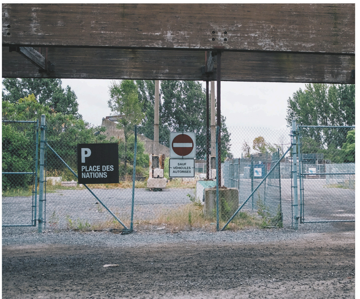
La Place des Nations est dans un état délabré et elle est barricadée à la suite d'effondrements.
