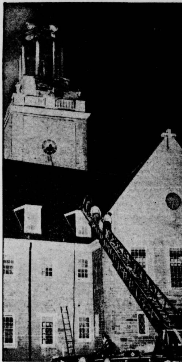
COUVENT DE HAMILTON, ONT., INCENDIE — Des dommages, évalués à $10,000, ont été causés par un incendie qui s'est déclaré au nouveau couvent des Sœurs de St-Joseph, à Hamilton, Ontario. Le feu a détruit la tour en bois de l'édifice de trois étages avant que les pompiers aient pu maîtriser les éléments et empêcher qu'ils se communiquent à la partie principale de la bâtisse. On croit que les flammes ont été causées par un court-circuit dû à des fils défectueux. Le couvent, construit au coût de $1,500,000, n'était pas habité. Son inauguration est fixée au 23 septembre prochain.
