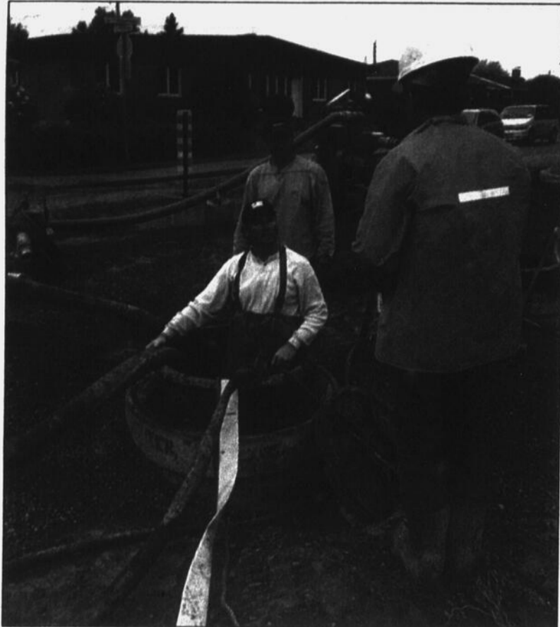
Les ouvriers du chantier ont commencé à pomper l'eau le lendemain de l'orage.
