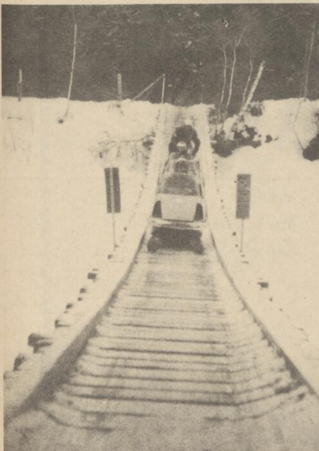
On pense à tout Le club Motoneige Granby donne l'exemple à d'autres clubs dans plusieurs domaines. Dernièrement, le club a construit un pont suspendu d'une longueur de 106 pieds, réalisé sur câble d'acier. Cette réalisation unique en son genre permet aux adeptes de la motoneige de traverser cette rivière en toute sécurité.
