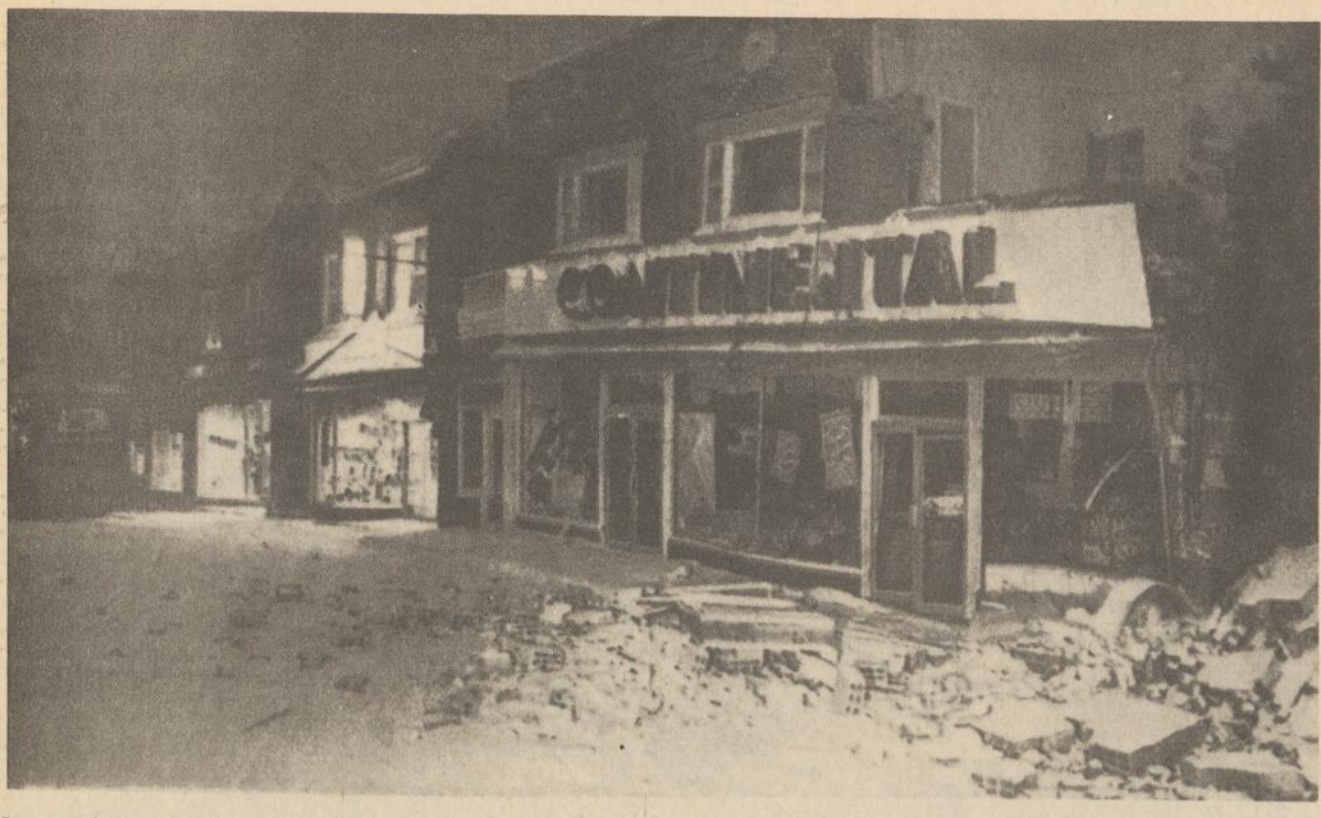
La population d'Asbestos vit dans la peur depuis l'affaissement de terrain des derniers jours et qui a été un des plus graves de son histoire. Cette ville de 10,500 habitants est en passe d'être engloutie par une gigantesque mine à ciel ouvert appartenant à la société Johns-Manville Limitée. Sept édifices commerciaux ont été endommagés et une dizaine de familles ont dû être évacuées.
