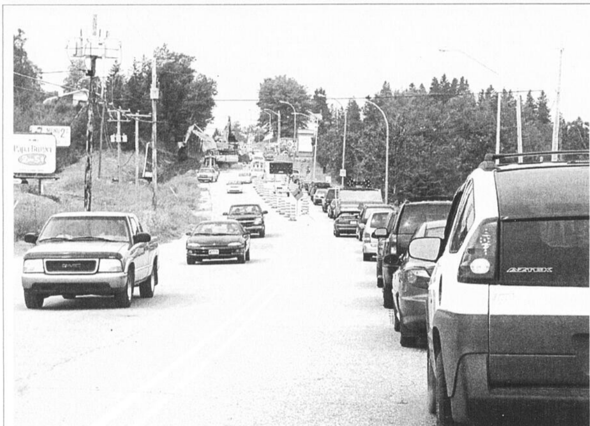
RÉFECTION - Les travaux de réfection de la côte St-Jean-Eudes à Jonquière occasionnent d'importants ralentissements de la circulation aux abords du chantier. Les automobilistes devront prendre leur mal en patience encore quelque temps avant de rouler sur une chaussée flambant neuve.
