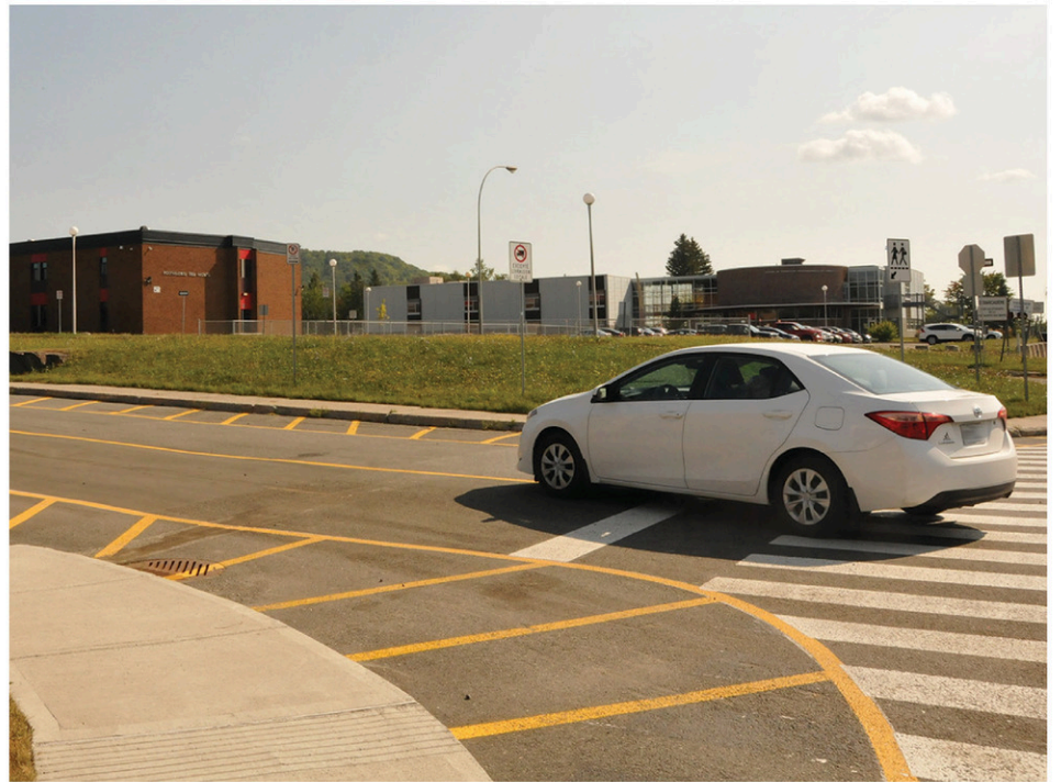
Une partie des travaux de sécurisation piétonne entourant la Polyvalente des Monts ont été réalisés, mais l'intersection des rues Légaré et Brissette était encore pareille en date du 25 août. (Photo L'info du Nord - Maxime Coursol)
