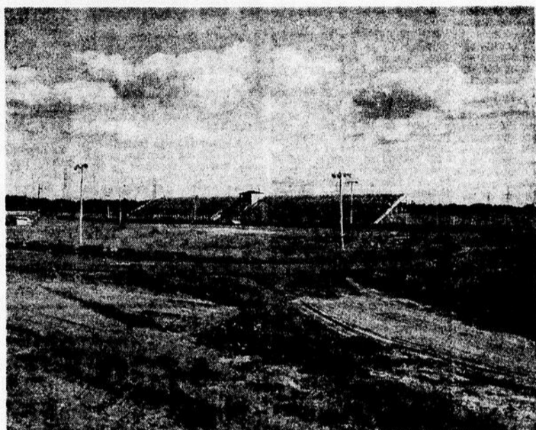
Cette photo nous fait voir la piste de l'Autodrome de la Mauricie Inc entièrement rénové. Une magnifique estrade a été construite pour le confort et la sécurité des spectateurs.
