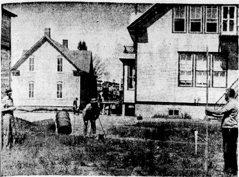
L'ÉCOLE DE Ste-Monique sera déplacée sous peu. M. Armand Marcotte, entrepreneur de Nicolet, se regarde l'alignement du nouveau site, assisté de ses employés, et à préparer le terrain. Effectivement, le jour ou nous sommes rendus à Ste-Monique, on commençait à faire l'excavation. Sur le terrain où était l'ancienne école, on construira l'école centrale de Ste-Monique.
