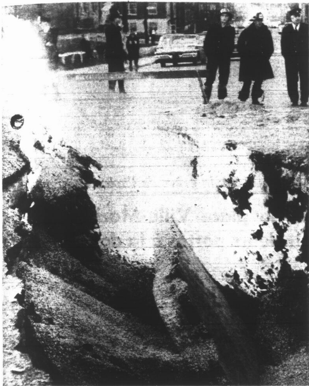
Une fausse manoeuvre d'une pelle mécanique a fait tomber un immense bloc de ciment sur un tuyau de gaz naturel, samedi après-midi, à l'angle des rues Légaré et De Lapettrie, dans le quartier Côte-des-Neiges. L'incendie s'est déclaré lorsque le gaz a atteint la flamme d'une torche de circulation. Il a fallu plusieurs heures aux ouvriers de la compagnie de gaz naturel pour arrêter finalement les fuites de chaque côté du tuyau. Plusieurs rues des environs ont été bloquées par la police! Tandis que les pompiers se tenaient prêts à toute éventualité. (Photo Bernard Lauzé)
