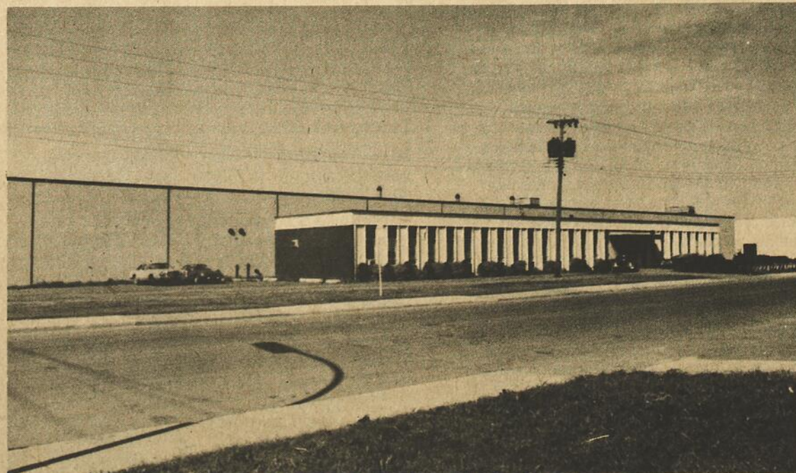
Façade du nouvel entrepôt loué au 10,500 Parkway à ville d'Anjou.
