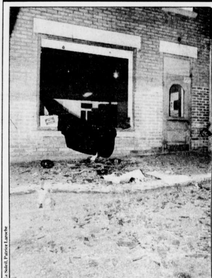
La maison a été lourdement endommagée lors de l'explosion.
