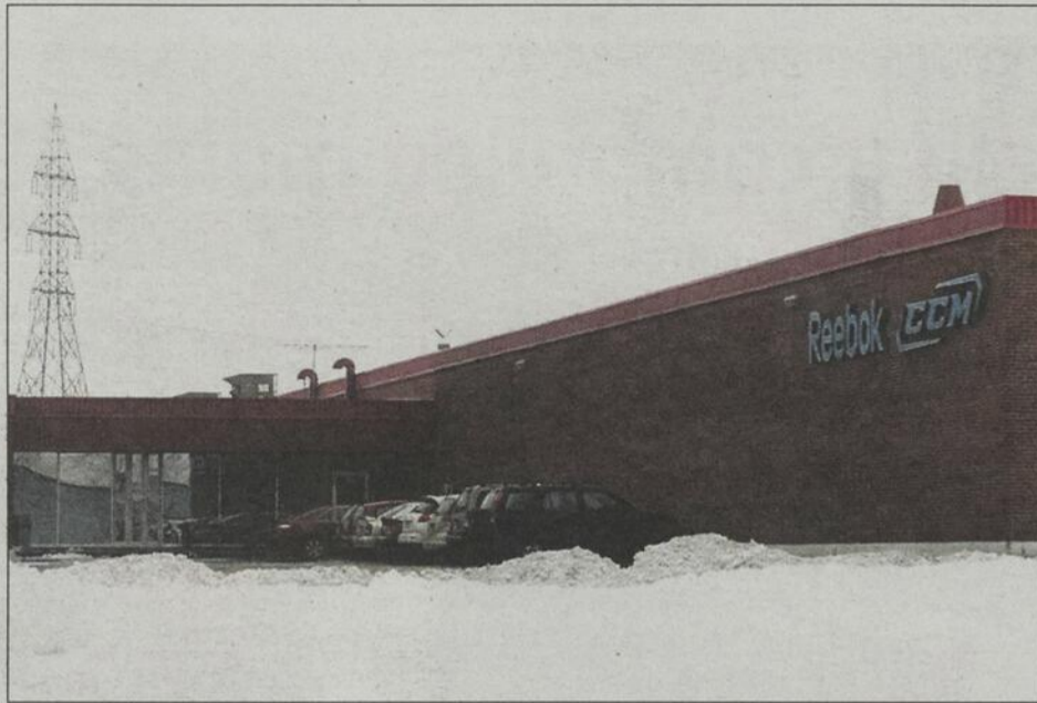
Ce n'est pas la première fois que d'importantes coupures de postes sont effectuées au sein de l'usine qui, au cours de ses années les plus prospères, employait plus de 800 personnes.
