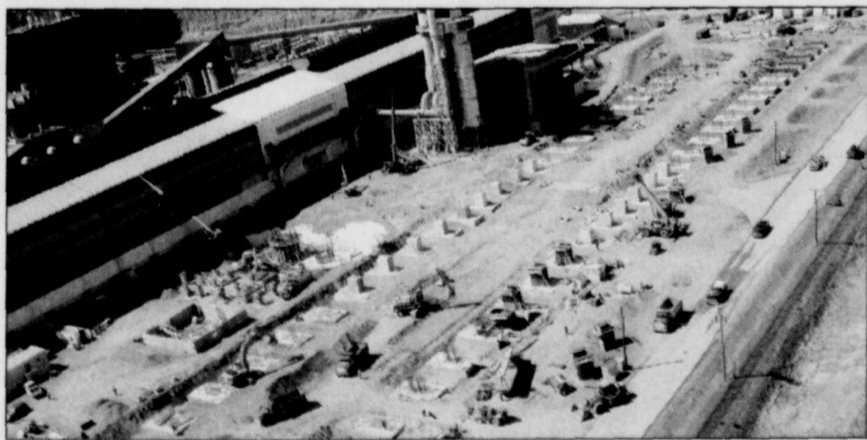
Alouette est actuellement le plus gros chantier au Québec.
