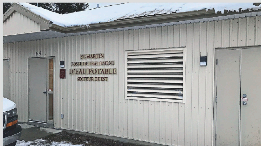
L'usine de traitement d'eau du secteur ouest de Saint-Martin.
