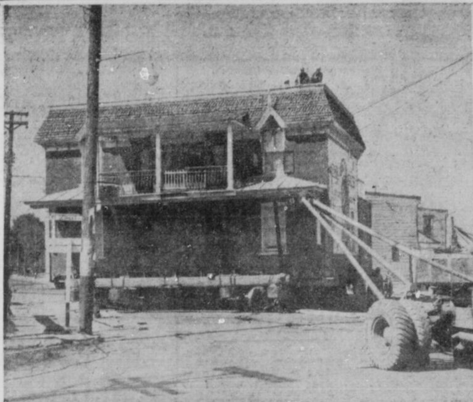
DEMEMAGEMENT D'UNE VILLE A UNE AUTRE — Deux scènes du déménagement sur rouleaux d'une maison qui a été transportée de Ville Le Moyne à Greenfield Park, soit sur une distance de \frac{3}{4} de mille, au cours de la journée
