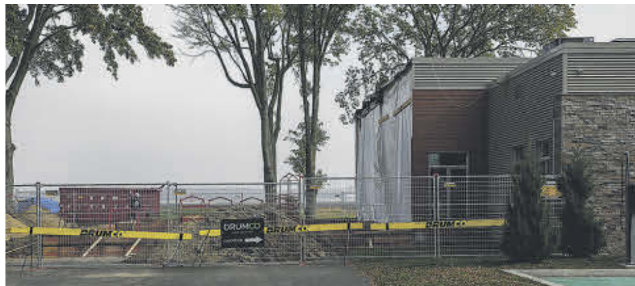
Les travaux d'agrandissement du Centre de services municipaux de Saint-Gérard-Majella ont commencé le 27 septembre dernier. Photo Pascal Cournoyer | Les 2 Rives ©
