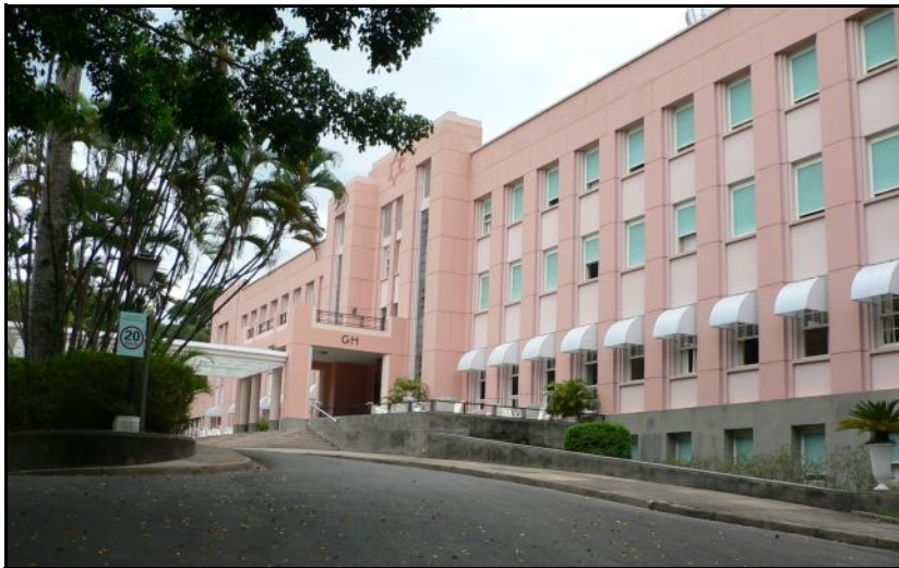
Figure 6.20: Grande Hotel, Águas de São Pedro.
