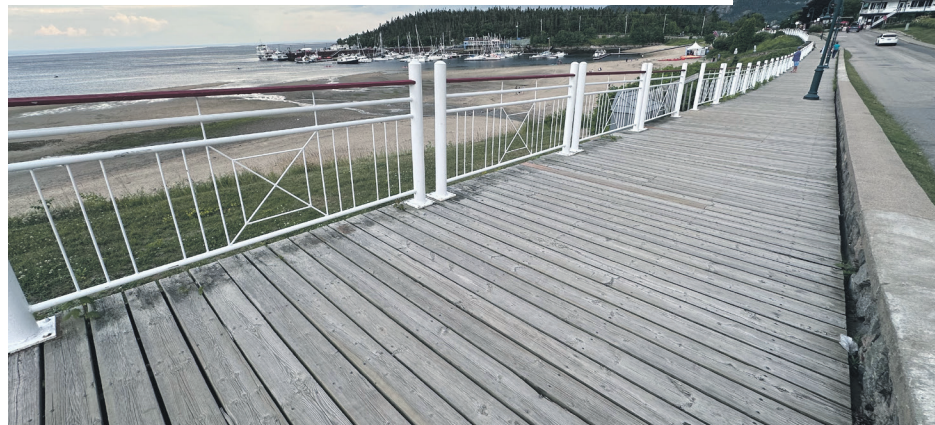
Les travaux de réaménagement commenceront cet automne. Photo Johannine Gaudreault
