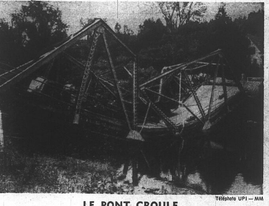
LE PONT CROULE SOUS UNE CHARGE TROP LOURDE Le pont qui relie Sugar Hill à Franconia dans l'Etat du New Hampshire s'est écroulé, lors d'un lourd camion-remorque, chargé de lames d'acier a heurté la structure du pont. Les deux occupants du camion ont été blessés dans l'accident. Il s'agit de deux résidents de Providence, R.I., MM. John Sousa, 50 ans et Joseph Evans, 22 ans, qui reposent dans un état satisfaisant à l'hôpital de Littleton, N.H. Téléphoto UPI - MM
