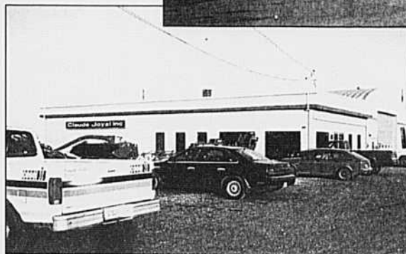
Stanbridge Station depuis 1991
