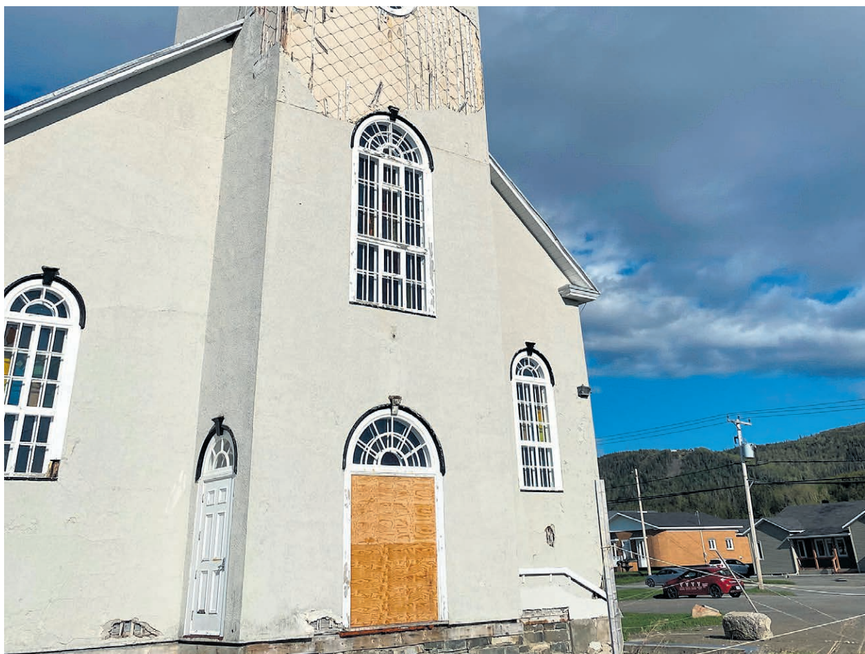
L'église Saint-François-Xavier a été construite en 1910. Une violente tempête survenue en 2020 avait rendu les portes principales inopérables et le parvis avait dû être démolé.
