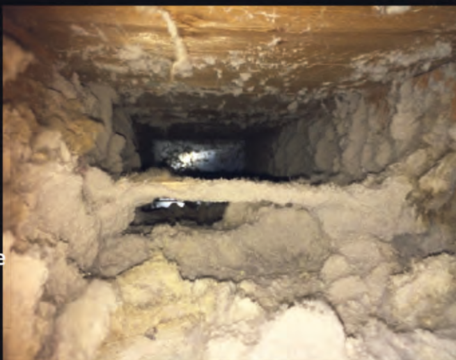
* Conduit de retour d'une fournaise à l'huile
