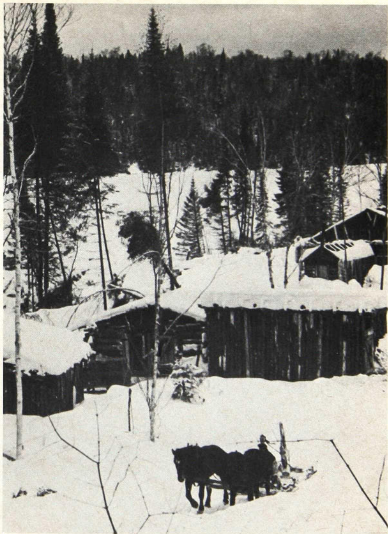
Chantier, au début du siècle. Probablement en Gatineau. (Archives Deschâtelets, Ottawa.)
