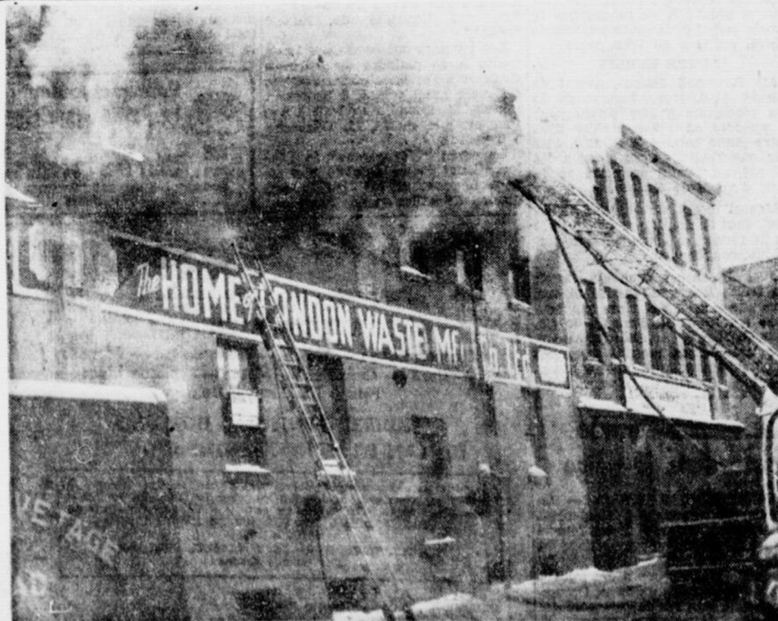
POMPIERS ALERTES RUE CLARKE. — Cet instantané fut pris, hier soir, lors d'un incendie qui se déclara au deuxième étage de l'édifice de la Home London Waste Mfg. Co., 998, rue Clarke, et y causa de lourds dégâts.
