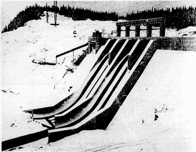
Voici un type de déversoir, celui qu'on appelle le saut en ski. Cette forme de déversoir empêche l'érosion.
