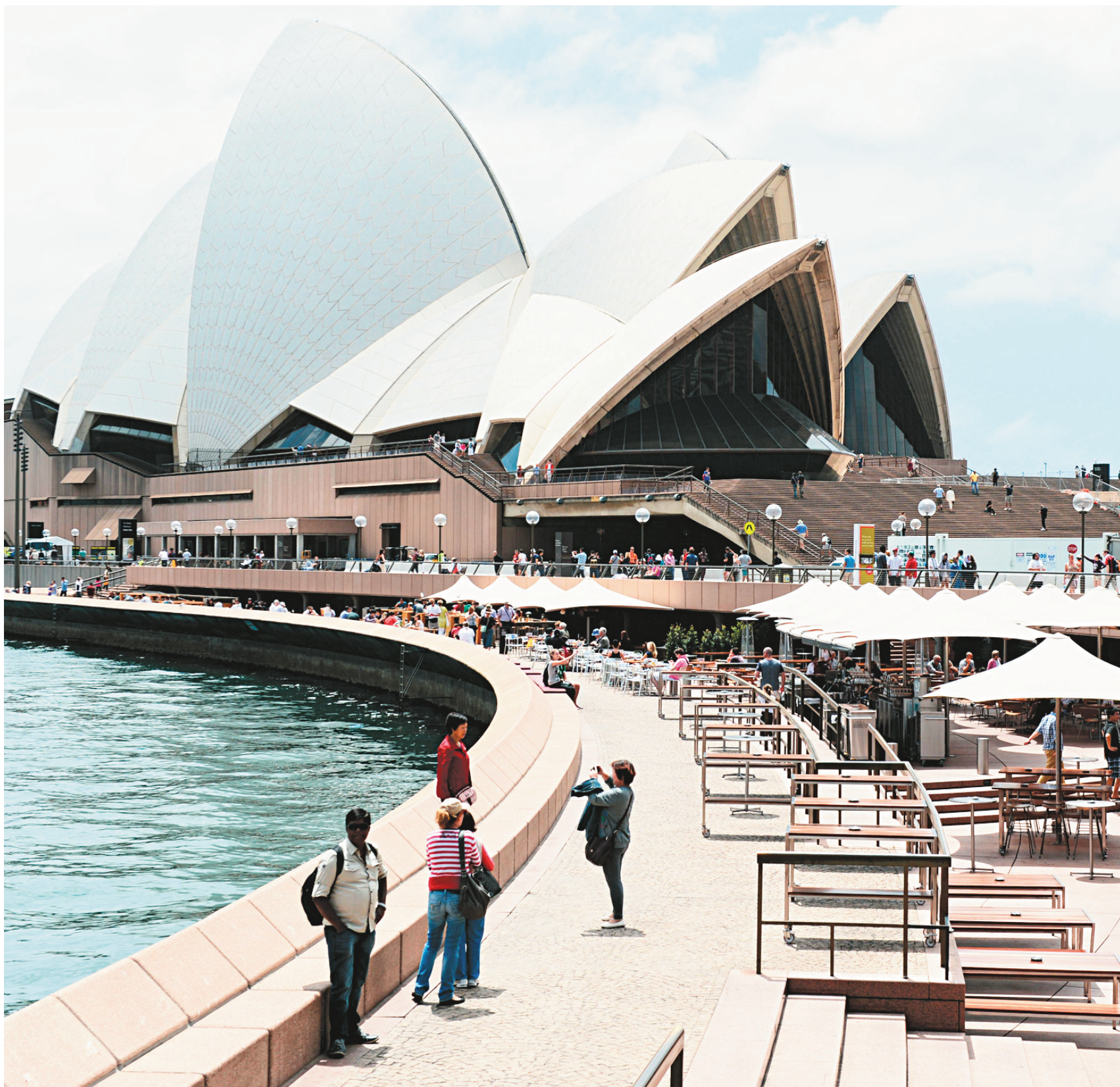
Le quai circulaire entourant la Maison de l'opéra à Sydney, en Australie.
