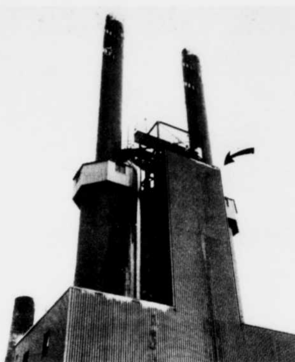
Le travail des pompiers était compliqué. Il fallait à la fois travailler en hauteur avec un minimum d'espace de manoeuvre, défaire une bonne partie de la toiture tout en luttant contre le vent et le feu. La flèche indique l'endroit où le feu a fait ses ravages.
