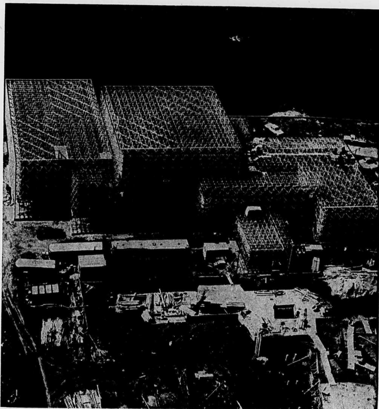
Le pavillon des Pays-Bas dont la structure d'acier capte l'attention, est, comme on peut le constater, fort avancé.
