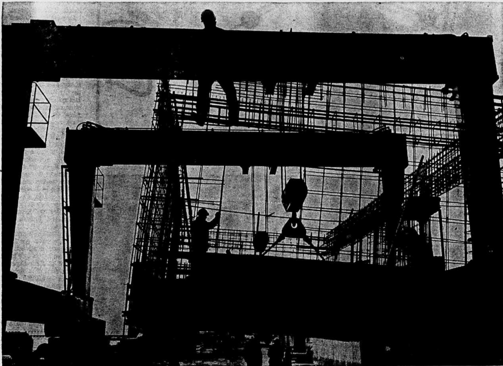
Tout est prêt pour couler la première unité d'Habitat 67. Les ouvriers placent l'armature d'acier avant de couler le béton.
