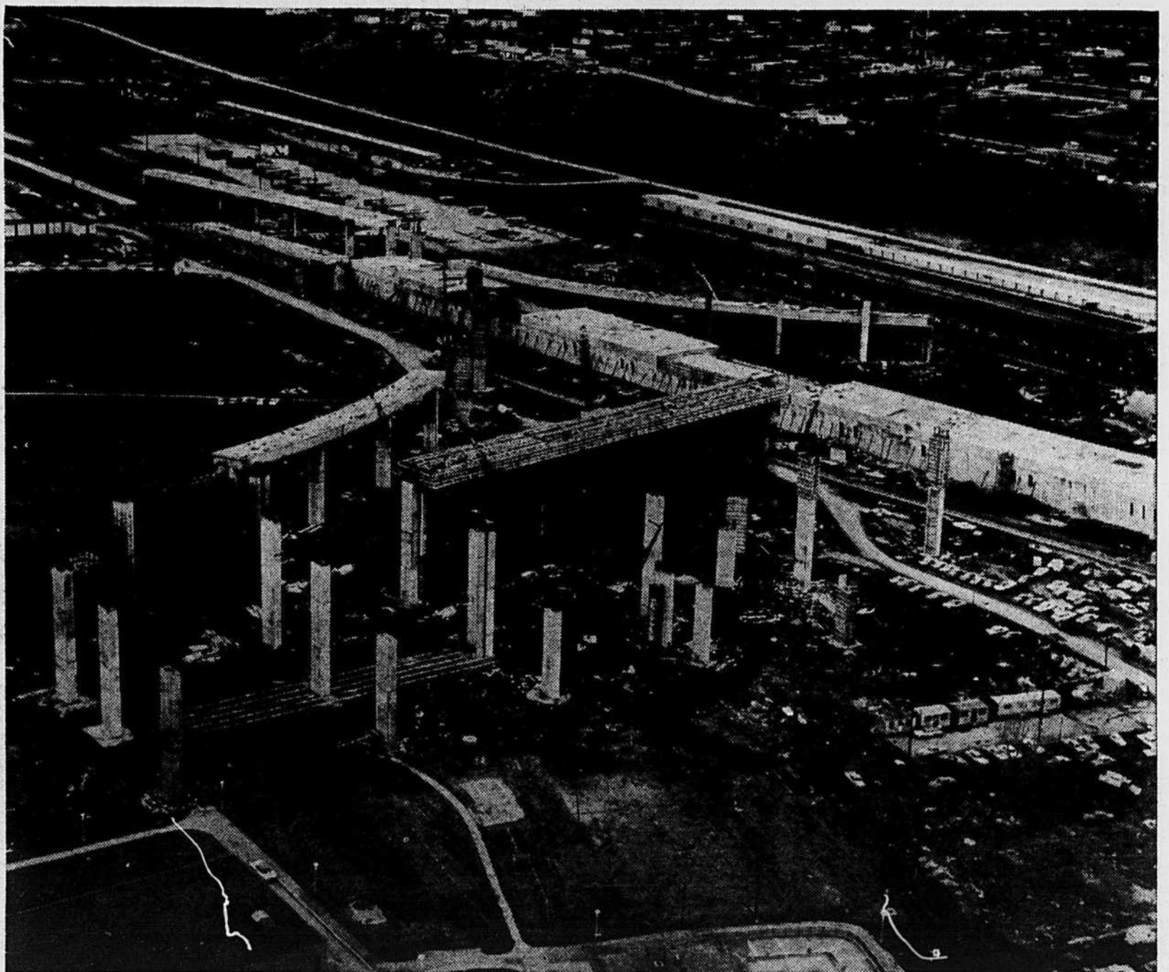
La Transcanadienne amènera son flot de visiteurs. Cette photo montre les travaux qui se font à l'échangeur Turcot.
