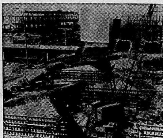
4.— PAVILLON THEME DE L'HOMME A L'OEUVRE (en voie de construction)
