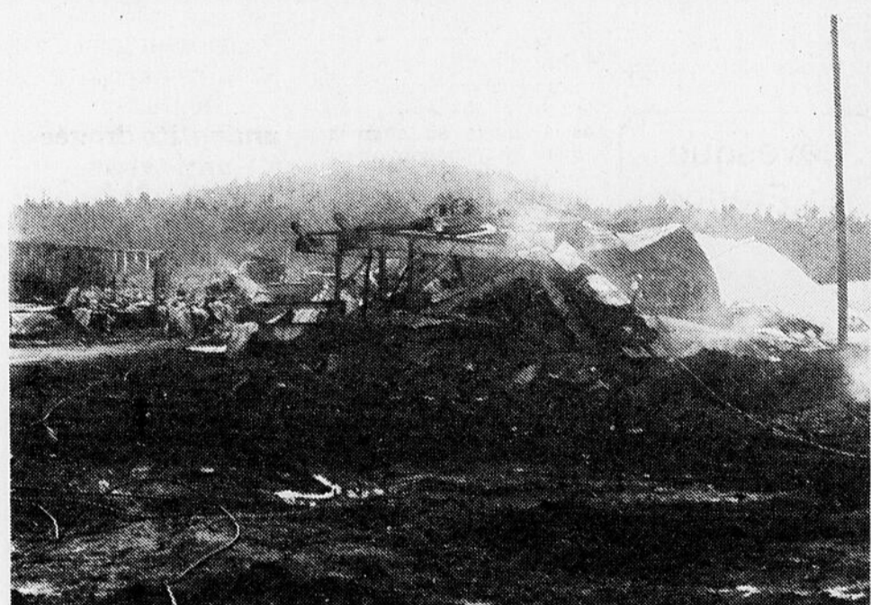
DOMMAGES $500,000 — Ce n'est qu'au cours de la semaine prochaine que les actionnaires de la maison Mailloux & Frères décideront s'ils reconstruisent ou non la
