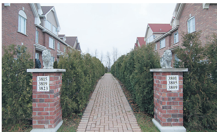
Le 3823, rue Céline-Marier, et cinq autres maisons ont une entrée commune perpendiculaire à la rue.
