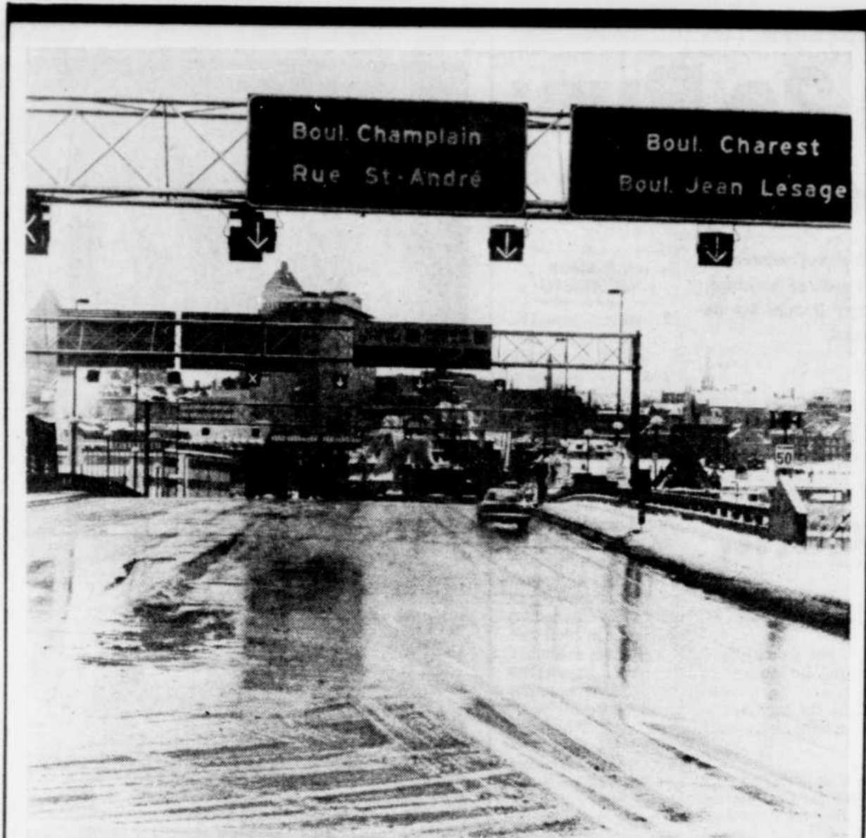
Tunnel Joseph-Samson rouvert
