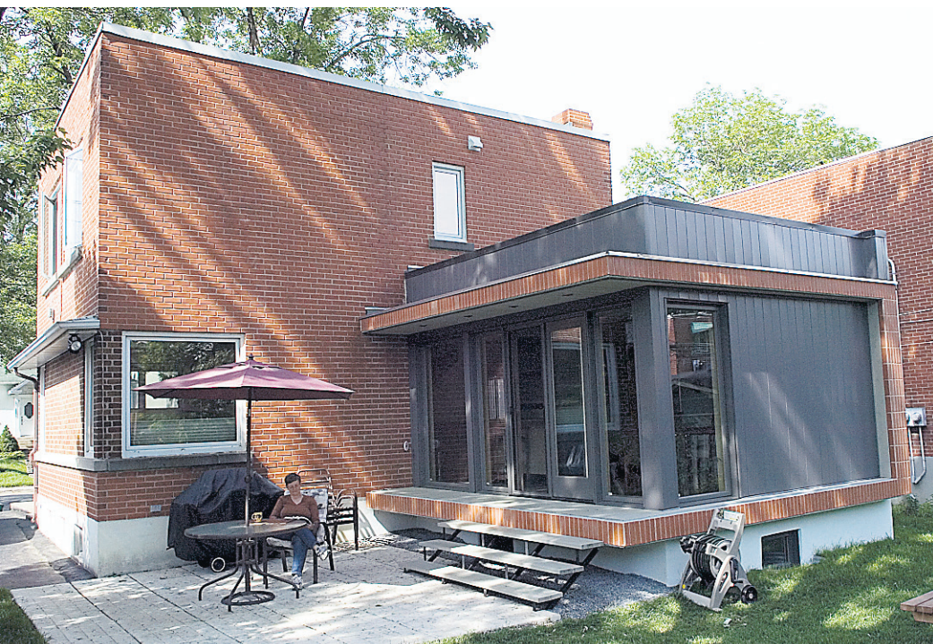
PHOTO FOURNIE PAR LES PROPRIÉTAIRES Le style art déco du cottage a inspiré les architectes pour concevoir cet agrandissement.
