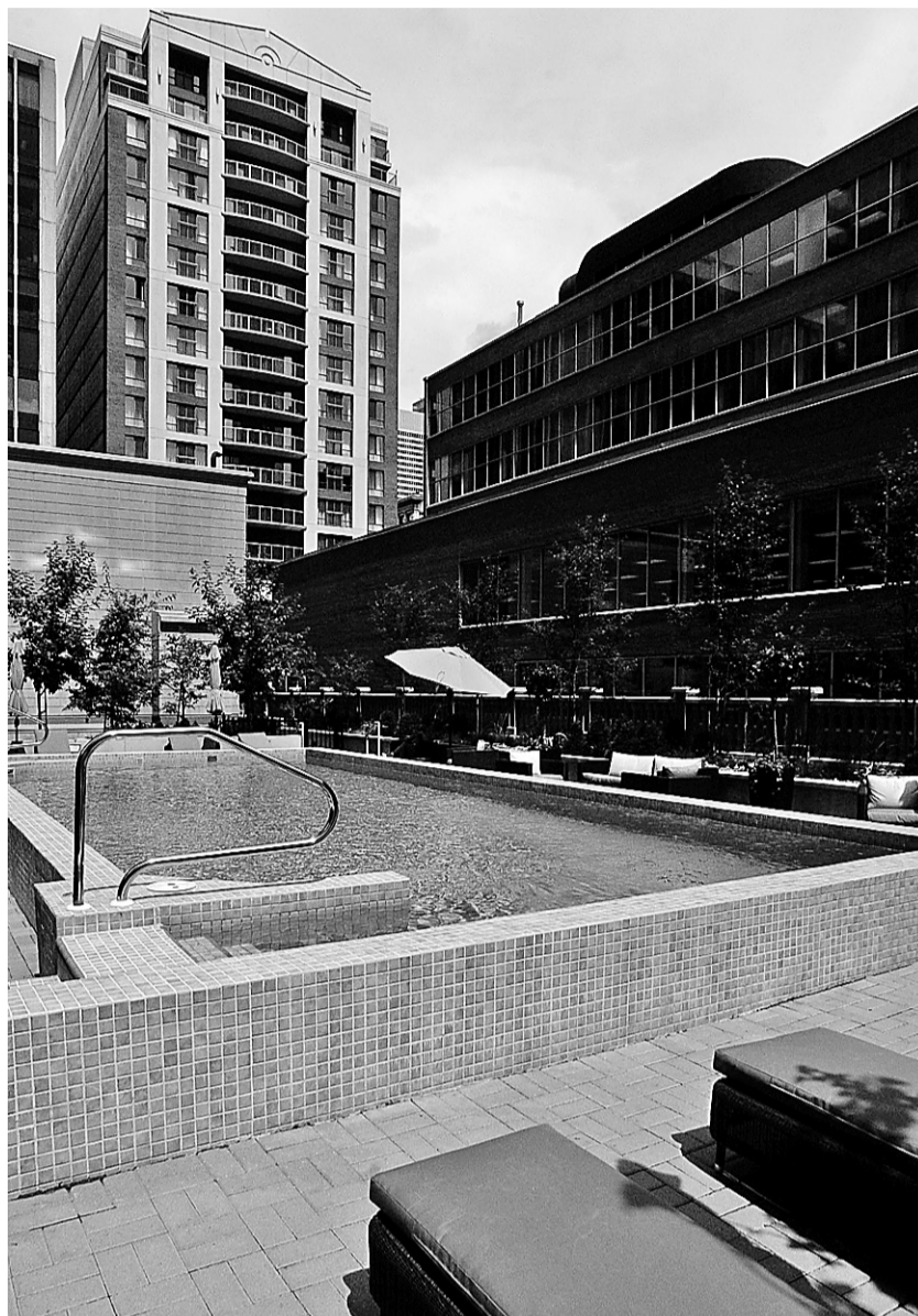
Située au-dessus du garage intérieur, entre les deux tours, la piscine donne un air de lieu de villégiature à ce complexe immobilier.
