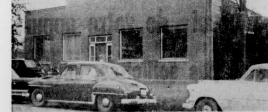
Vitrierie Magog — On voit sur cette photo l'édifice de la Vitrierie de Magog Inc, que la cité de Magog serait intéressée à acheter en créant un fonds industriel. Comme son nom l'indique, cette firme fabrique des miroirs de toutes sortes.
