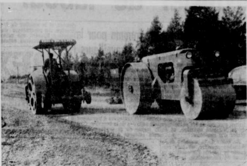
Travaux de pavage. — La machinerie de la firme Fabi et Fils travaille depuis quelques jours à la préparation de la rue Bowen, à Magog, avant d'y poser une couche d'asphalte. On voit que des travaux de pavage évalués à $140,000 ont débuté tout récemment à Magog, et que plusieurs rues seront pavées.
