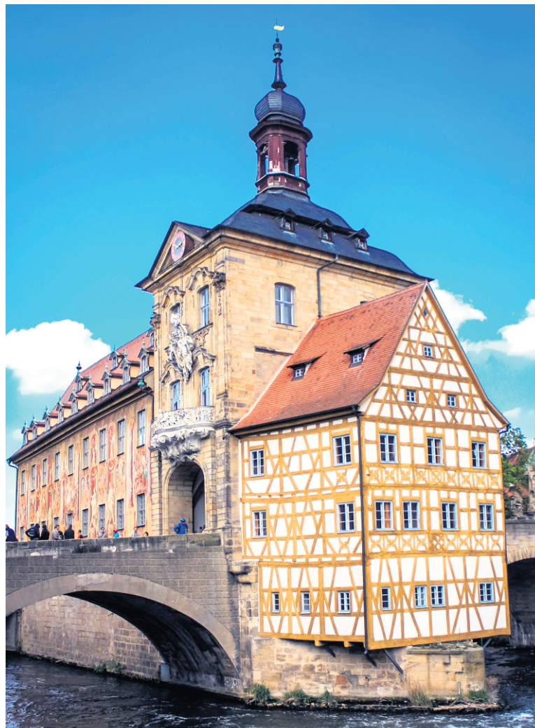
Accessible par le pont Obere, l'ancien hôtel de ville de Bamberg est un chef-d'œuvre sur pilotis.
