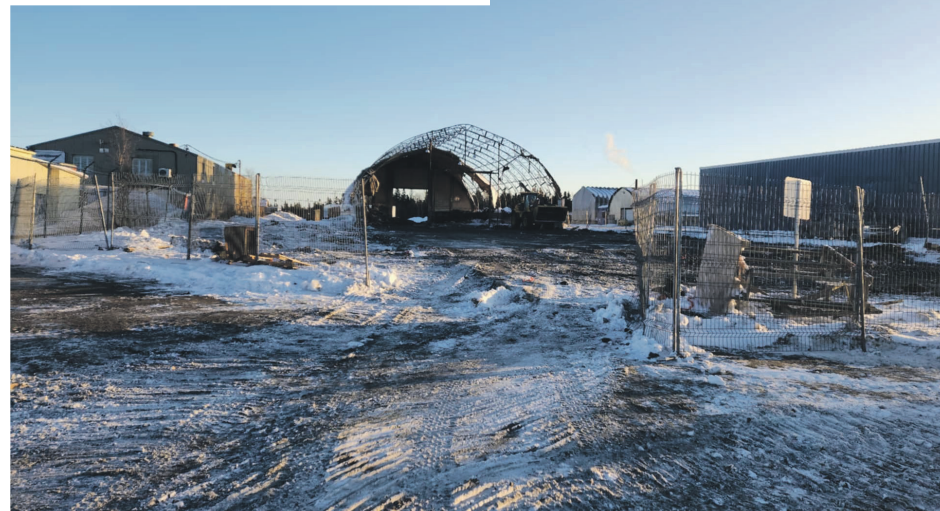
Suite à la démolition du centre de tri, il restera une évaluation de la dalle de béton à effectuer. Photo courtoisie
