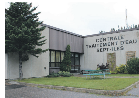
Amorcé en janvier 2024, le chantier de mise aux normes de la centrale de traitement d'eau de la Ville de Sept-Îles est maintenant complété. Photo courtoisie
