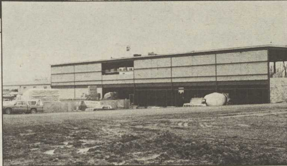
L'entreprise de Saint-Césaire a procédé au cours de l'automne à des travaux d'agrandissement de $1 million qui ont permis d'augmenter la superficie de son usine de 44,000 pieds carrés. Photo du haut: M. Marcel Gervais, pdg des Meubles Gervais (à gauche), observe le travail de l'un des dessinateurs de l'entreprise, Jean-Michel Guillet, en compagnie de Michel Gervais, directeur des ventes et du marketing.
