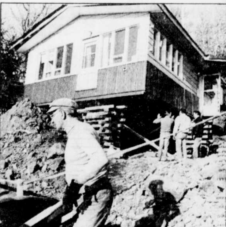
Le chalet était placé sur des blocs de bois pour construire des fondations. M. Paradis, coiffé d'une casquette, travaillait avec la victime André Beaudry lorsque l'accident est arrivé. Il a réussi à sortir rapidement de sous la maison.
