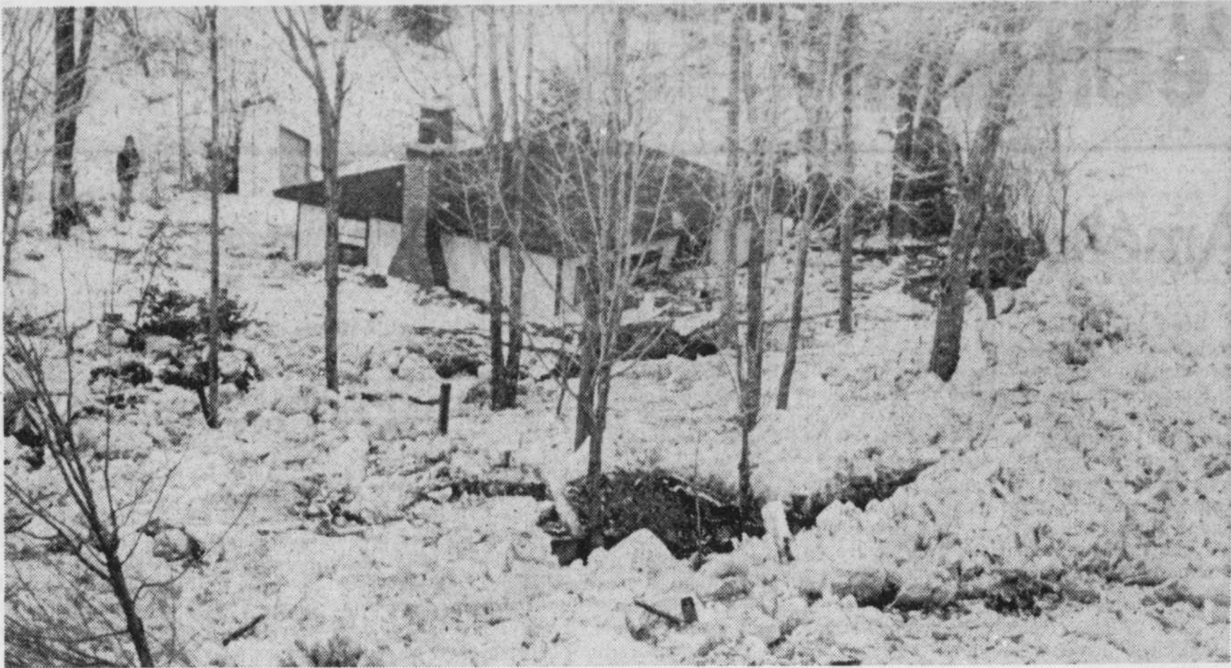
Une autre résidence que la rivière Montmorency a engloutie et lourdement endommagée.
