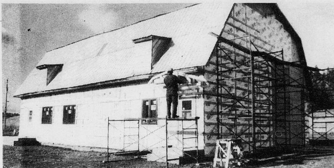
SUR LE CHANTIER - L'ancienne grange Benjamin, est en voie de faire peau neuve. (Photo Rocket Lavoie)
